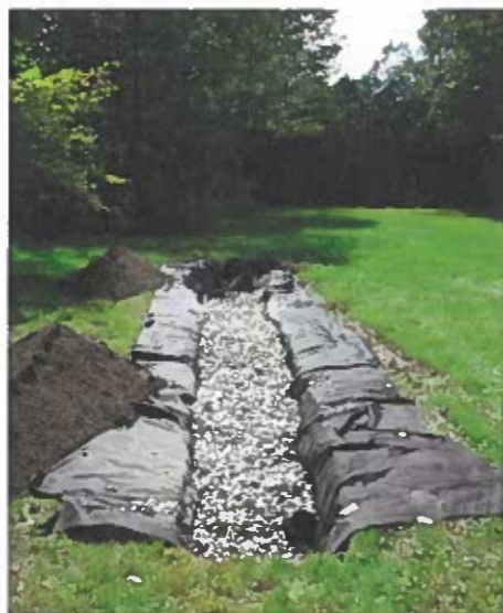
Figure 1 : Exemple de tranchée d'infiltration
